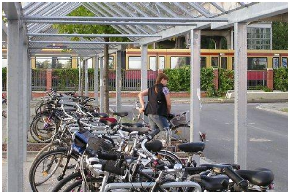
Przykładowe miejsce postoju rowerów przy dworcu kolejowym
