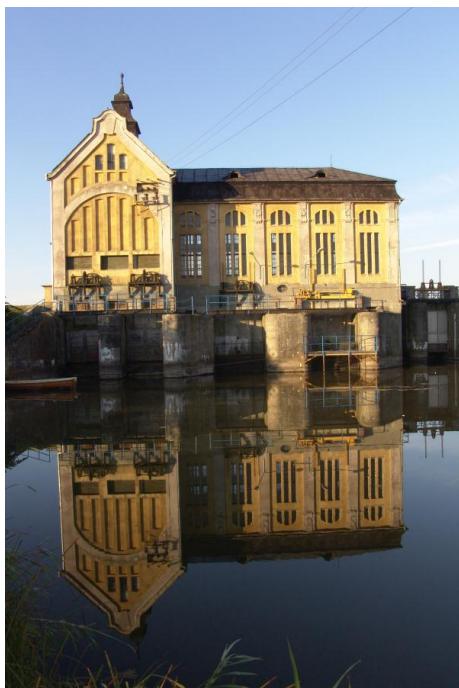
Przepompownia w Warnikach Fot. Piotr Chara
