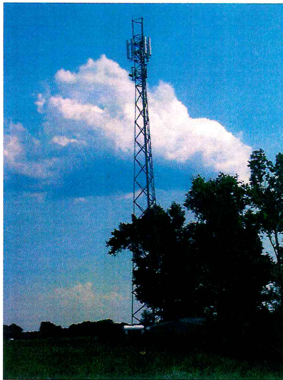
Zał. nr 1: Widok ogólny instalacji radiokomunikacyjnej.
